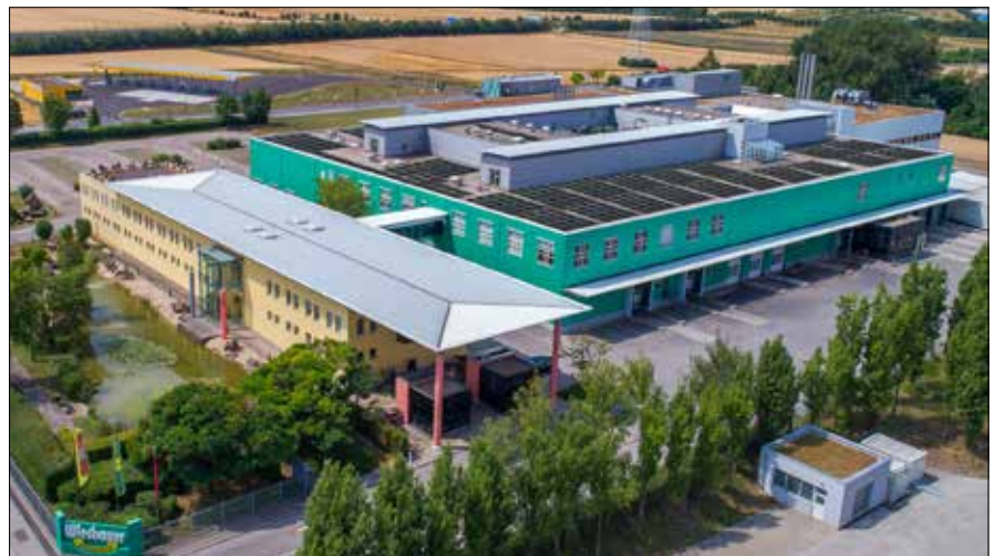
Die neue Photovoltaikanlage am Dach des Produktionsgebäudes von Wiesbauer
